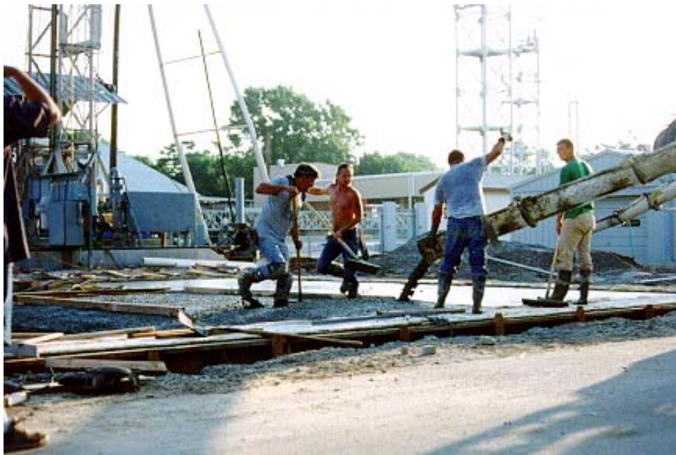
Fig. 3.7 Concrete pouring
