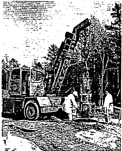
(d) Placement of wastes in auger hole (ORNL photo 60817).
