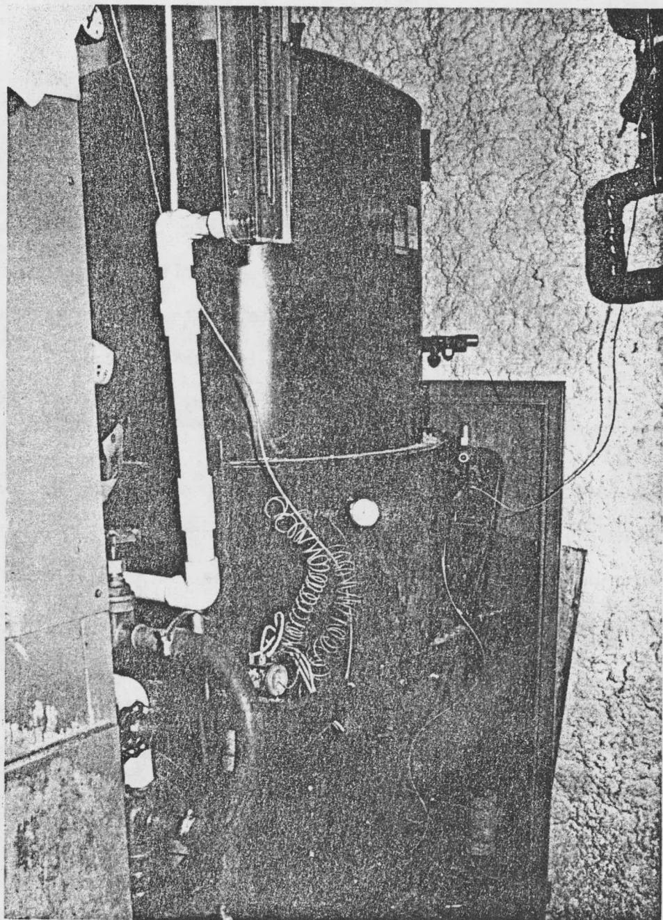
Figure 2.3.1. Arkla Solaire WF-36 Absorption Chiller
