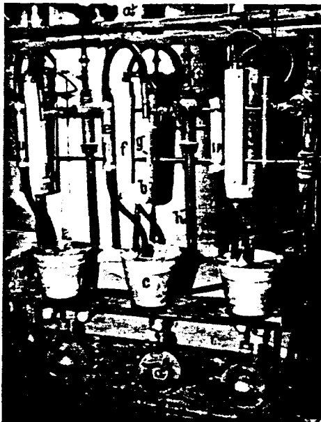
Bild 21. Flugstaub-Probenentnahme vor dem Luvo bei Ölfeuerung (Teilansicht).
