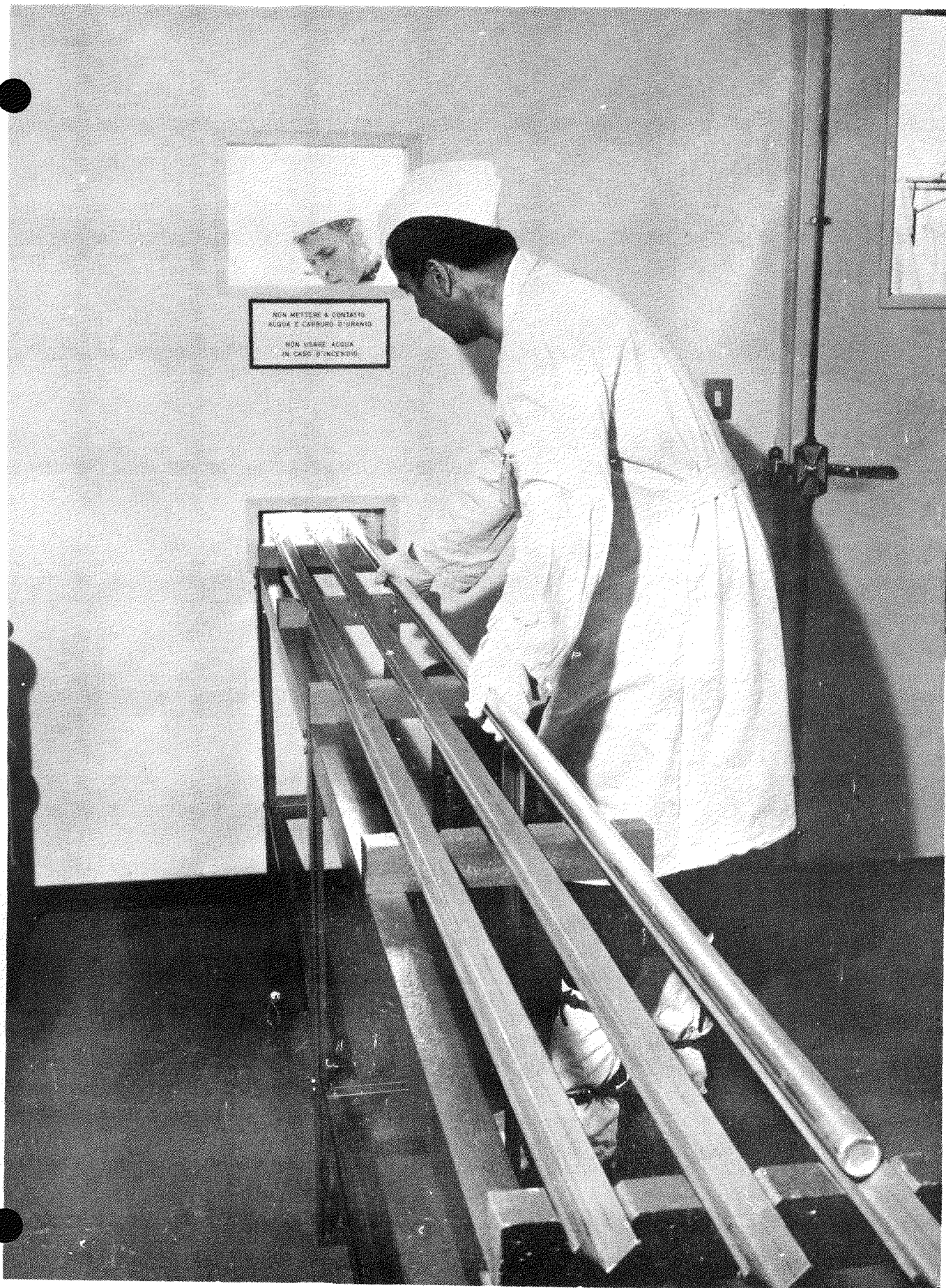
Fig. 11 : Remplissage des crayons
