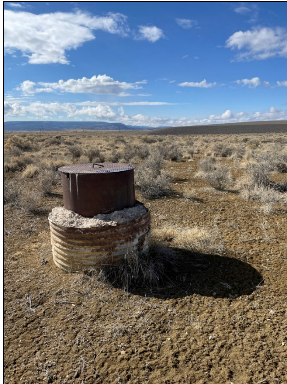
PL-5. Mine Vent Shaft
