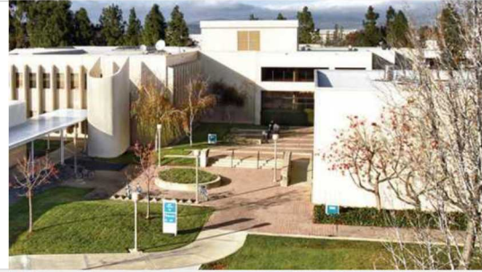
CA Bldg C940 (BAS)
