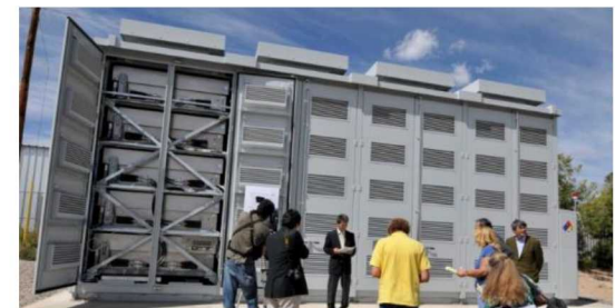
Los Alamos, NM. 1 MW, 6MWh
