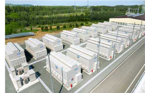
NGK 34MW - 245 MWh NaS Rokkasho, Japan
