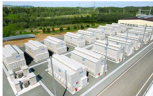
NGK 34MW/245 MWh NaS Rokkasho, Japan
