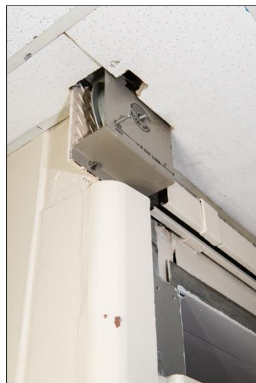
Close-up of end stop for blast door (DSC2615).
