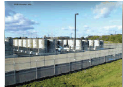
Yankee Rowe: Nac-MPC MPC canisters
