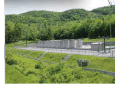
Yankee Rowe: Nac-MPC MPC canisters
