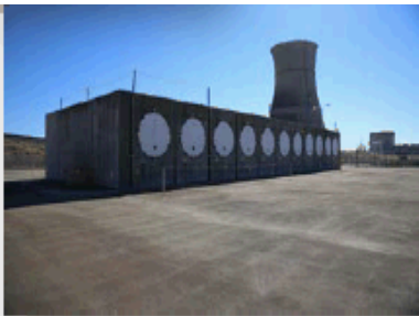
Rancho Seco: TransNuclear Nuhom canisters
