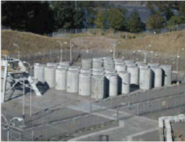
Trojan: TranStor Holtec MPC canisters
