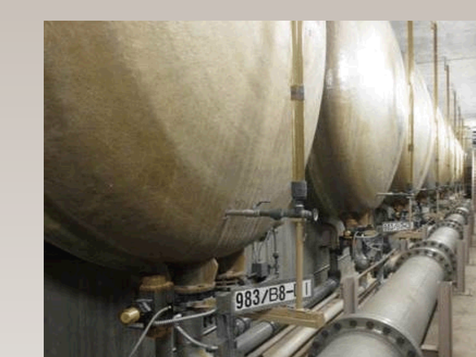
DI Water Storage Tanks
