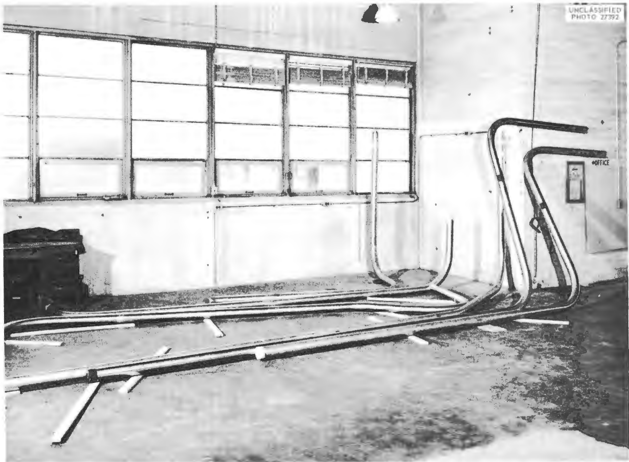
Fig. 1.5.10. ETU NaK Piping.
