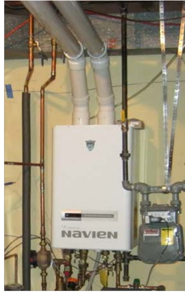
b) 2 pipe vent system
