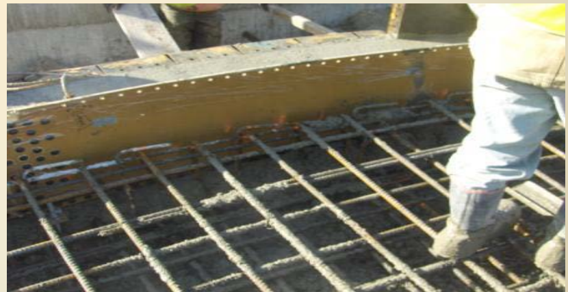
Pouring Reactor 1 Slab
