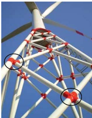
Fig. 2.5.2 Weserwind cast steel nodes
