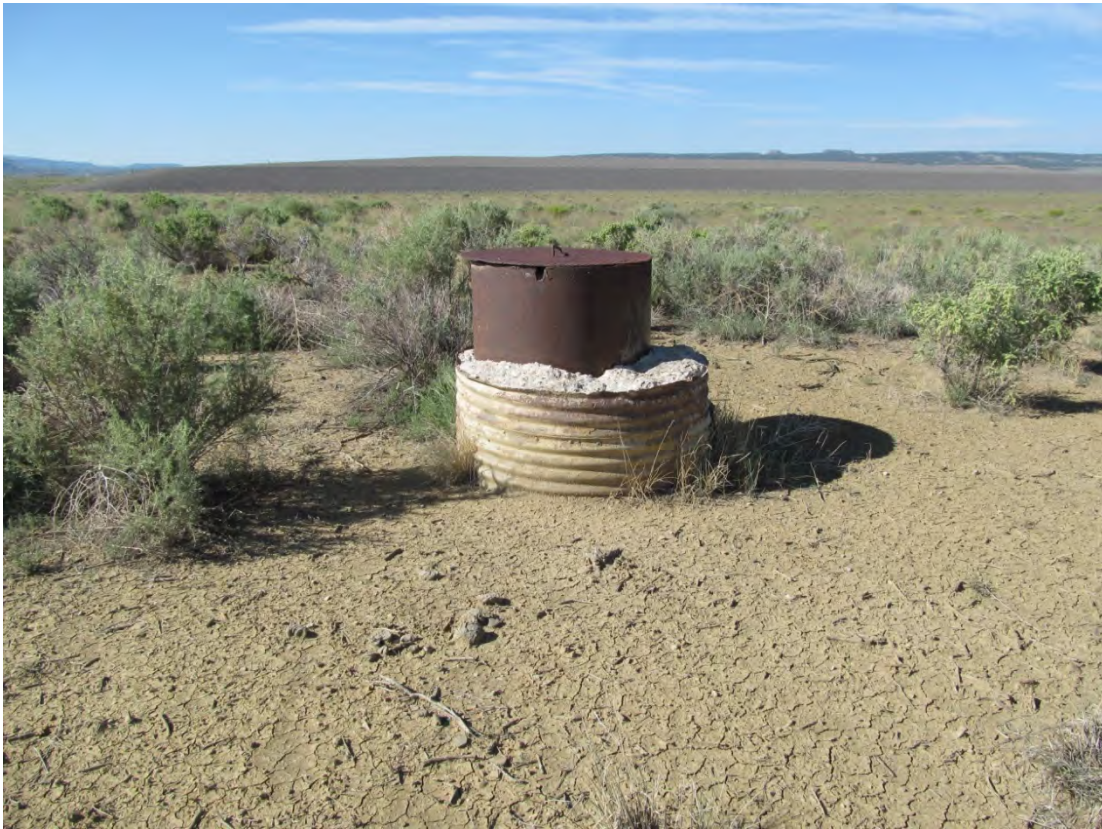
AMB 8/2013. PL-4. Secured mine vent shaft.
