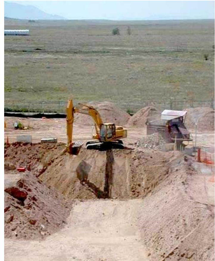
Landfill Excavation VCM
