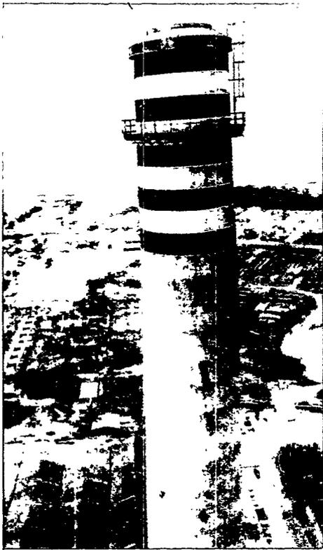
tos: a) arrastre estático; b) empujes dinámicos paralelos y transversales al flujo principal causados por turbulencia, y c) vibraciones transversales al flujo causada por vórtices alternantes.
