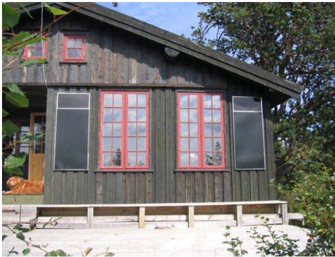
Figur 18: Luftsolfangere på en hytte i Telemark (www.hytteavisen.no).
