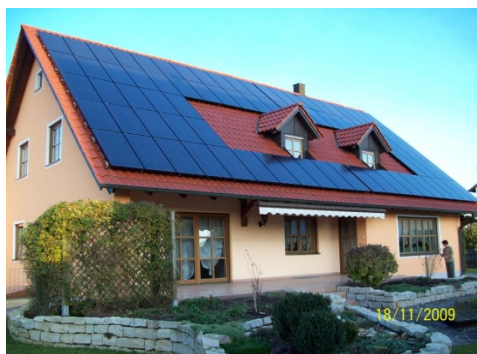
Figur 10: Solcelleanlegg montert på eksisterende tak [14].
