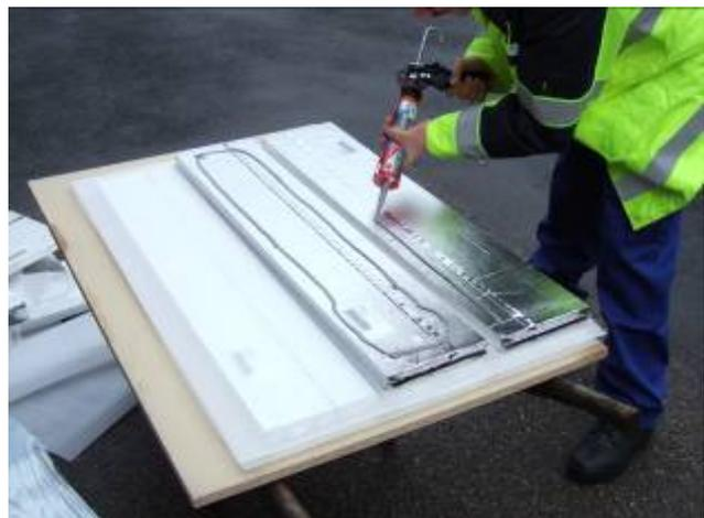
Abbildung 27: Links – Jedes VIP ist mit einem Aufkleber mit Abmessungen, Positionsnummer und Auftragsnummer versehen.
