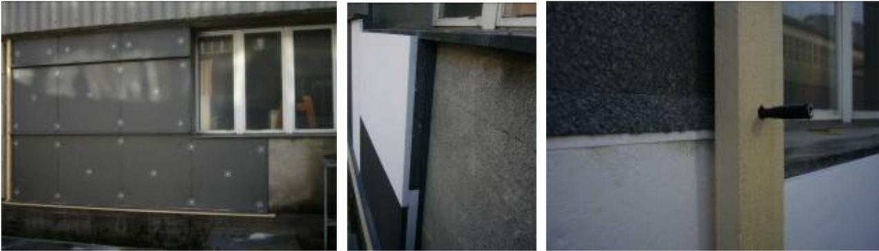
**Abbildung 20: Testmontage des Distanzschraubensystems mit einer versetzt zweilagigen VIP-Anordnung in Randbereichen und an Öffnungen zur Reduzierung der Anzahl notwendiger Paneelformate.** Bilder: swisspor
