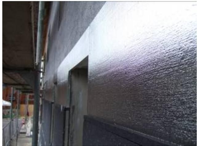
Abbildung 31: Links – Die äussere EPS-Schicht wird an den Rändern und Öffnungen nach Aufmass zugeschnitten und mit PU-Kleber auf die VIP geklebt.
