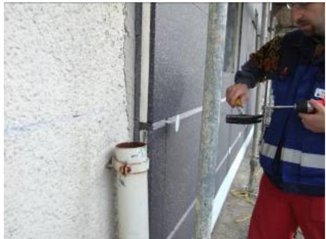
**Abbildung 30:** Links – In den horizontalen EPS-Streifen werden Löcher für die Kunststoff-Telleranker gebohrt. Später sitzen in den Horizontalstreifen auch die Distanzschrauben der hinterlüfteten Fassade.
