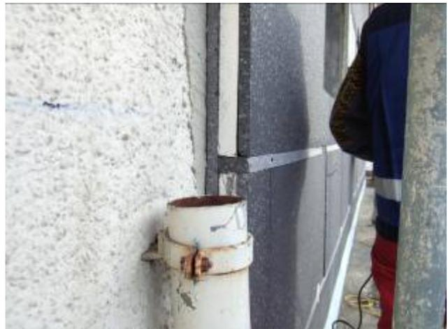
**Abbildung 29:** Links – Durch die äussere EPS-Schicht werden die VIP gut vor Beschädigung geschützt.
