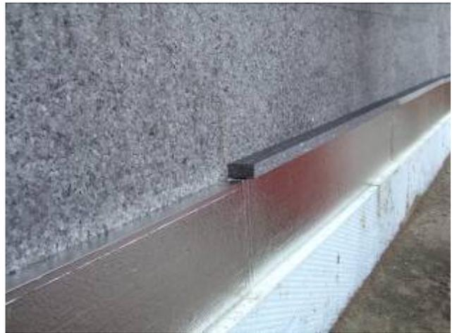
**Abbildung 28:** Links – Der Untergrund wurde zum Ausgleich der Unebenheiten vorgängig mit einer Lage EPS versehen. Die noch vorhandenen, leichten Unebenheiten können durch den PU-Kleber ausgeglichen werden.
