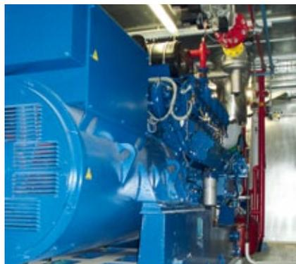
*BHKW-Aggregat einer Biogasanlage*
