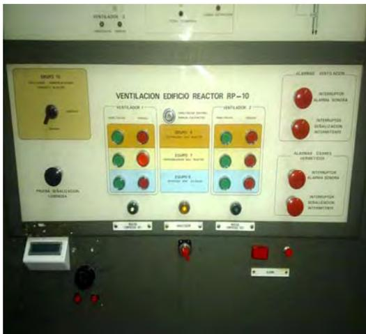
**Figura 1.** Imagen del tablero de control del sistema de ventilación del edificio del RP-10. Se observan al medio los pulsadores de arranque y parada de los ventiladores.
