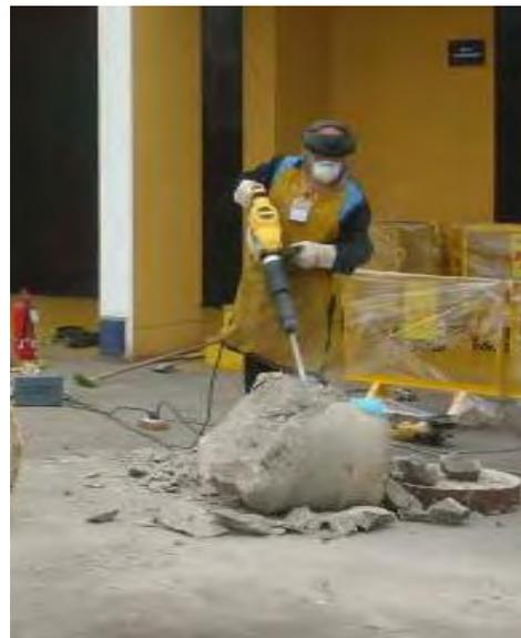
**Figura 3.** Retirando el material de cemento con indumentaria de seguridad.
