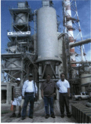
Fly ash silo
