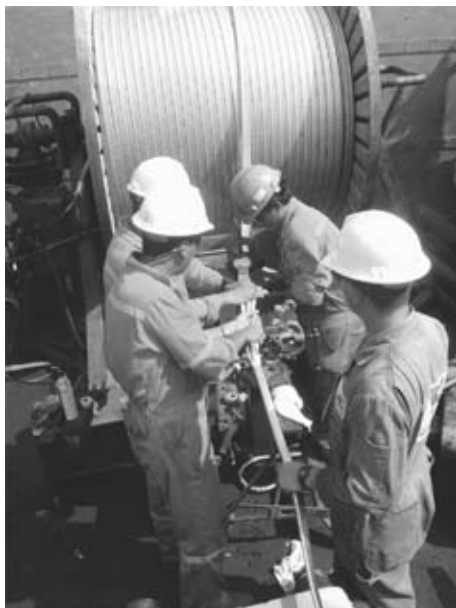
Figura 2. Instalación de empalme del cable de potencia, que interconecta el transformador elevador con la motobomba electrocentrífuga.
