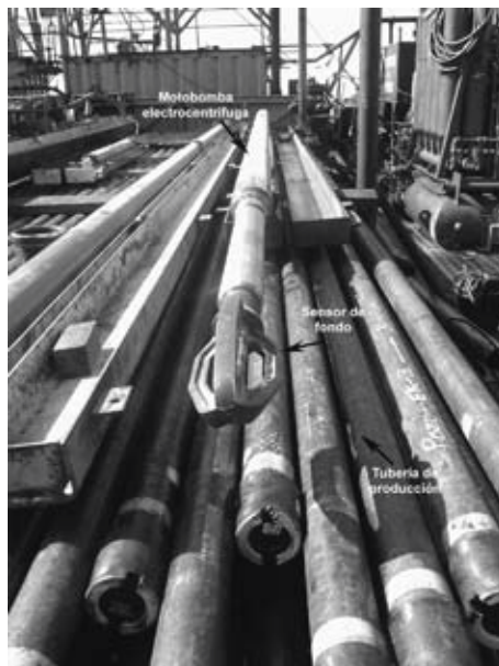
Figura 3. Motobomba electrocentrífuga ensamblada con el sensor de las condiciones de presión y temperatura del yacimiento, además de la tubería de producción, antes de instalarse en el pozo.
