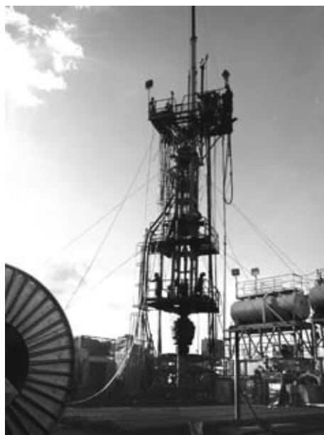
Figura 4. Vista de la torre de mantenimiento durante las maniobras de instalación en el pozo de la tubería de producción y de la motobomba electrocentrífuga.
