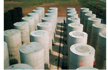
Área Seguridad Nuclear y Ambiente: Silos para almacenamiento en seco de combustibles gastados Central Nuclear Embalse Provincia de Córdoba
