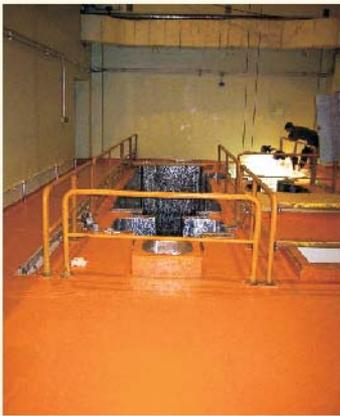
Proyecto LAPEP -Laboratorio de Ensayos Pos Irradiación: Pileta de recepción de elementos combustibles gastados Centro Atómico Ezeiza
