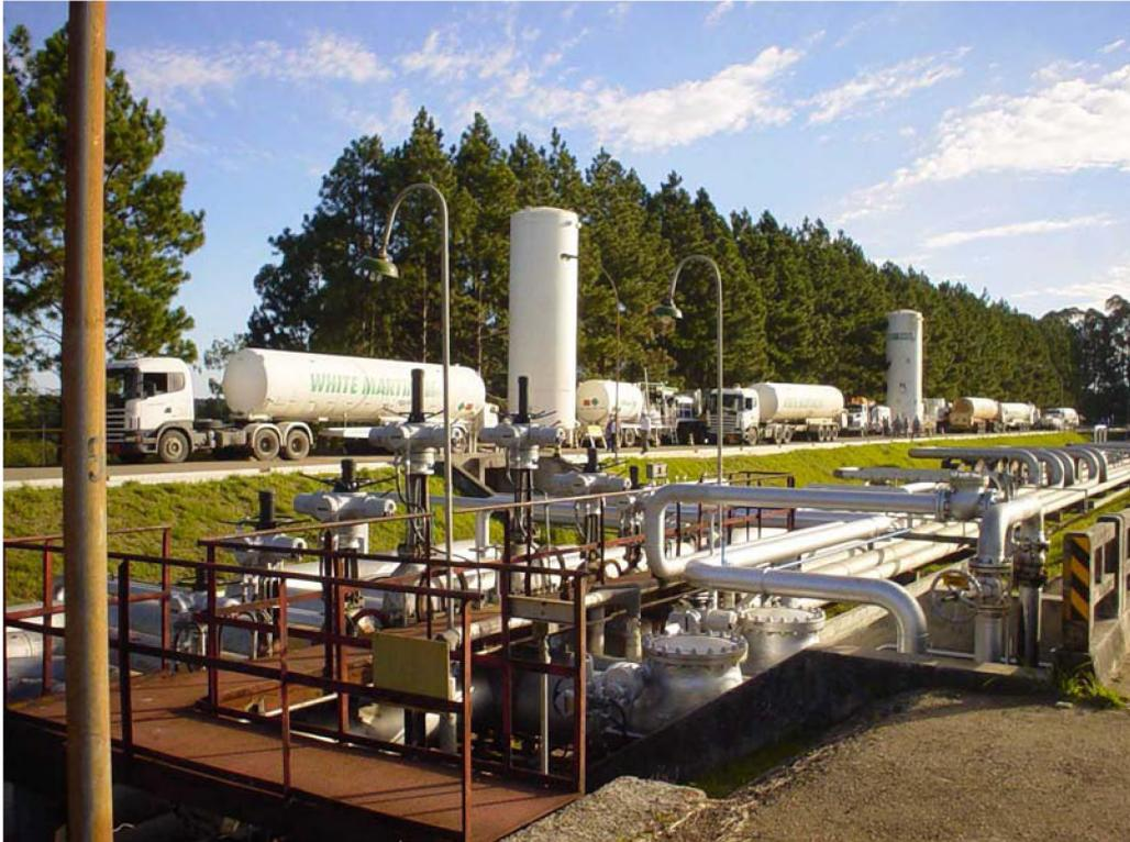
Figura 10. Equipamentos de bombeio e carretas de nitrogênio na REPAR
