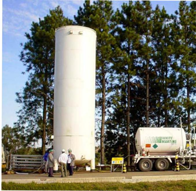
Figura 5. Tanque criogênio para nitrogênio líquido
