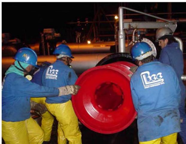
Figura 7. Pig sendo posicionado na câmara de lançamento
