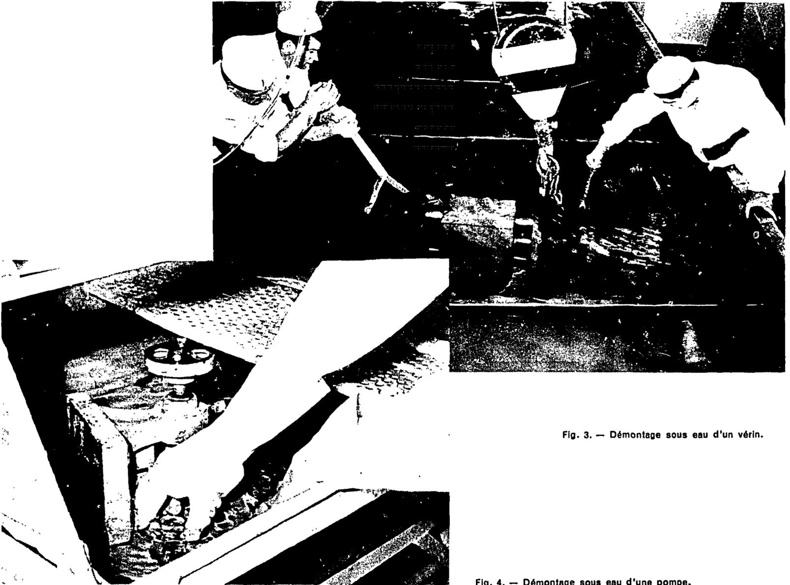
Fig. 3. — Démontage sous eau d'un vérin.
