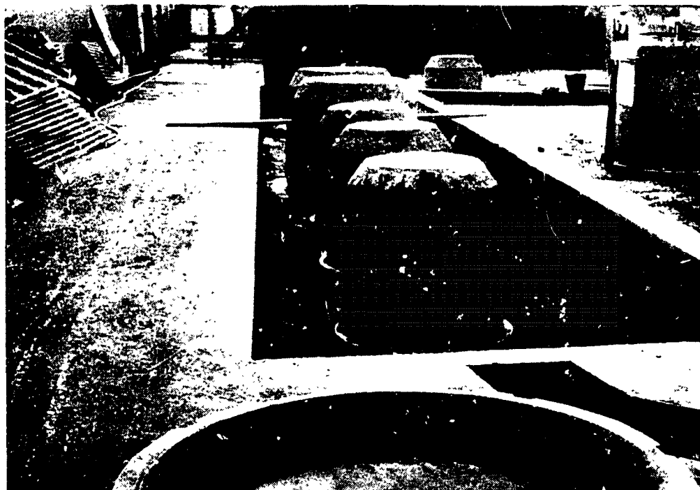
VIII - Blocs après injection et décoffrage.
