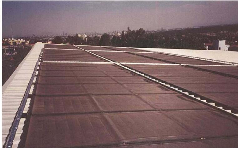
Figura 14. Campo de calentadores solares de plástico para el calentamiento de agua en una alberca. Cortesía de Imprema, S.A.
