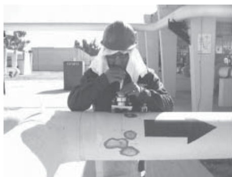
Figura 9. Centrado para barrenar.
