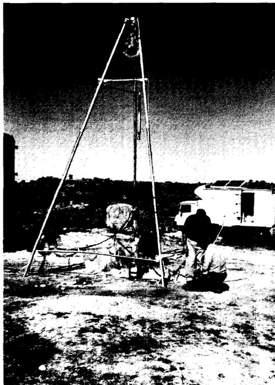
*Figura 4. Instalación del sistema de obturadores en las zonas más representativas del sondeo.*
