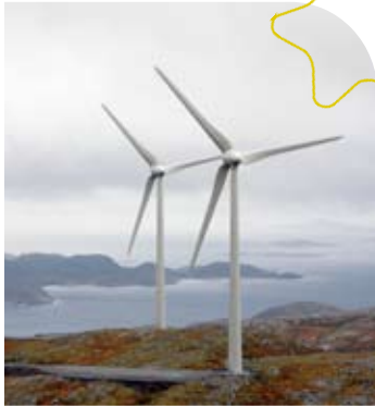
TrønderEnergi valgte turbiner fra det tyske selskapet Enercon. De 25 turbinene er hver på 2,3 MW og utstyrt med et girløst system som gir mindre slitasje.
